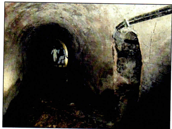
FOTO 12- Vista de part del refugi des del subsòl de l'avinguda de Madrid. A la dreta podem veure la claveguera que prové de la part occidental d'aquesta avinguda
