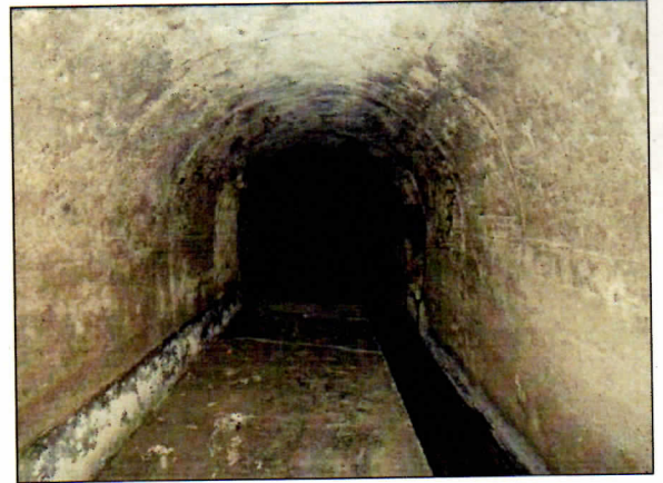
FOTO 22 - Vista general del refugi mirant cap el nord. Podem apreciar, al fons, els accessos tapiats que se situaven per sota Violant d'Hongria (antigament carrer de Iolanda)
