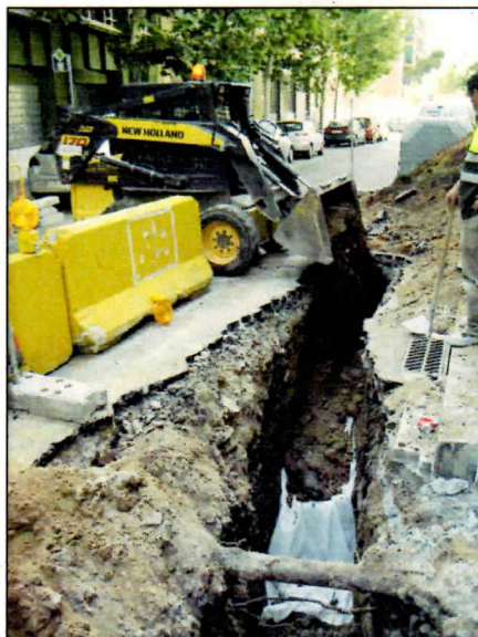
FOTO 05 – Després de documentar el tram exhumat es tornà a cobrir folrant-lo, prèviament, amb geotèxtil
