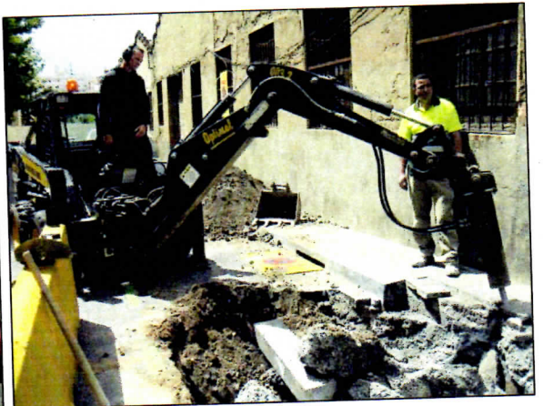
FOTO 02 – Inici de la cala de comprovació
