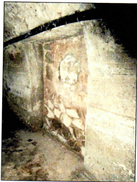
FOTO 11 – Accés original tapiat al costat de ponent, sota l'avinguda de Madrid. Aquest accés no hi figurava als plànols del projecte original
