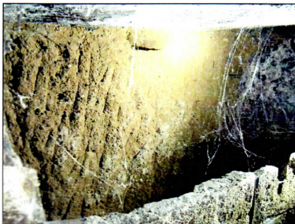
FOTO 19 – Detall de l'obertura anterior. Podem apreciar-hi els cops de pic en el substrat geològic
