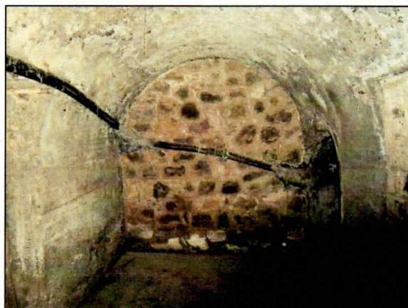
FOTO 08 – Extrem del refugi situat sota l'avinguda de Madrid. A la dreta podem apreciar la claveguera que entra al refugi per aquest punt
