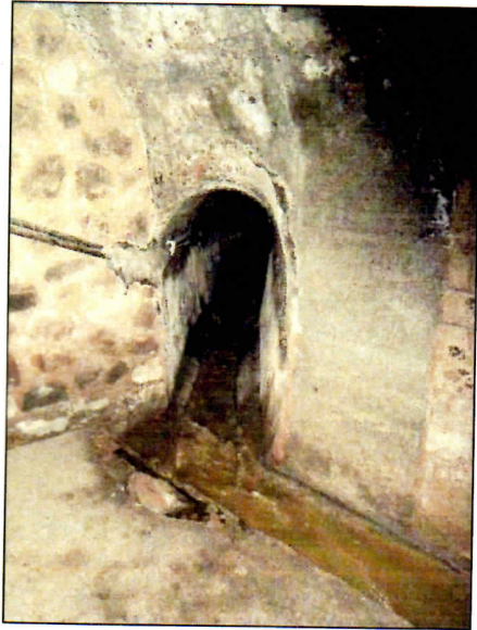
FOTO 09 – Detall de la claveguera que entra al refugi pel costat de llevant de l'avinguda de Madrid
